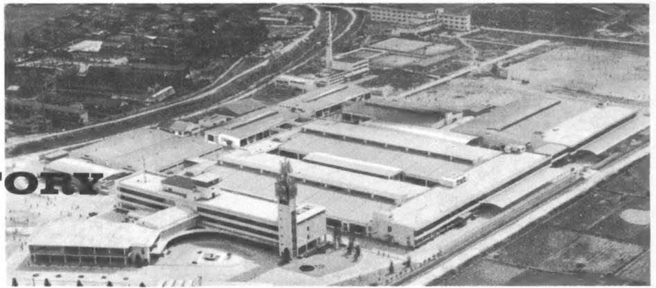
1 Million Fernsehgeräte jährlich werden von Matsushita Electric hergestellt. Unsere Luftaufnahme zeigt die Produktionsstätte für NATIONAL-Fernsehgeräte.
